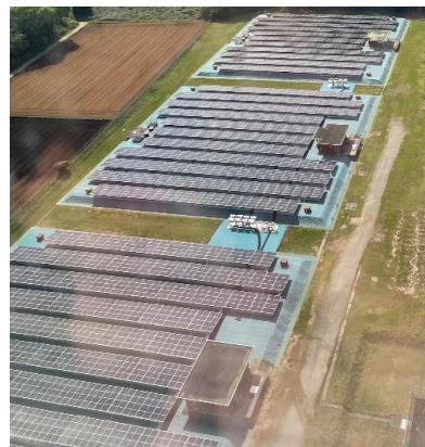
太陽光発電設備
