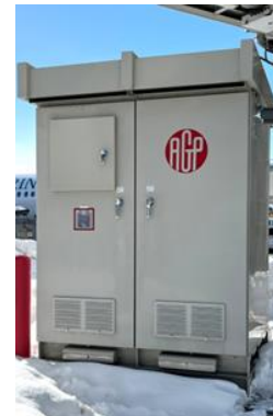
電力変換装置
