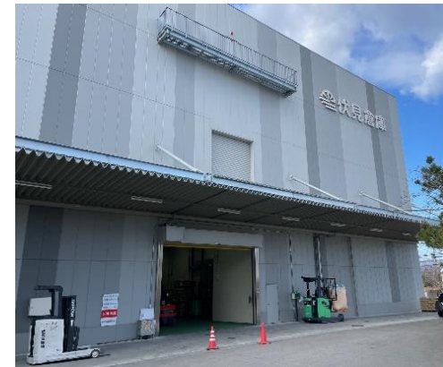
無人フォークリフトを運用している様子
