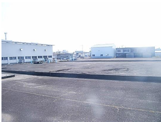
太陽光発電パネル設置前の配水池 （事業実施前）
