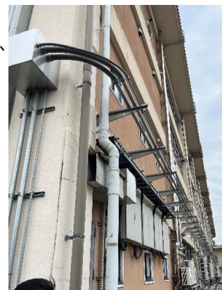
自営線 (DC1500V幹線、 DC380V幹線)
