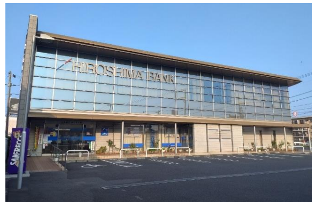
建物外観（広島銀行福山北支店）
