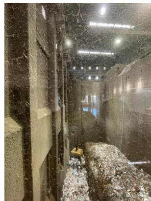
ごみクレーン
