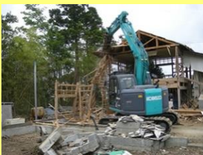
被災家屋等の解体
