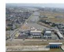
排水機場の整備
