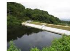
老朽化したため池の 全面改修
