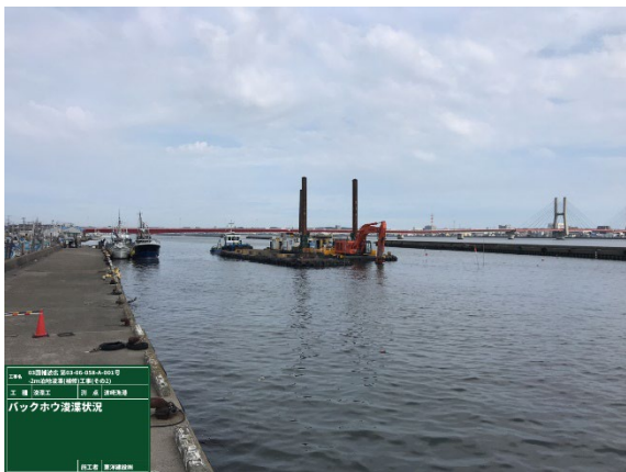
(バックホウ浚渫：水深が浅い場合)
