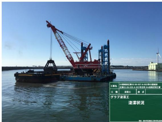
(グラブ浚渫：水深が深い場合)
