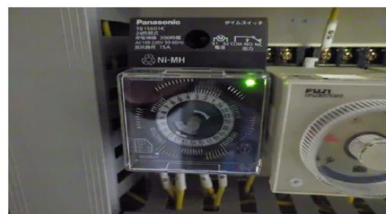
ばっ気ブロワ運転時間調整のためのタイマー設置
