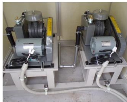
新設ばっ気ブロワ1台、原水攪拌ブロワ1台
