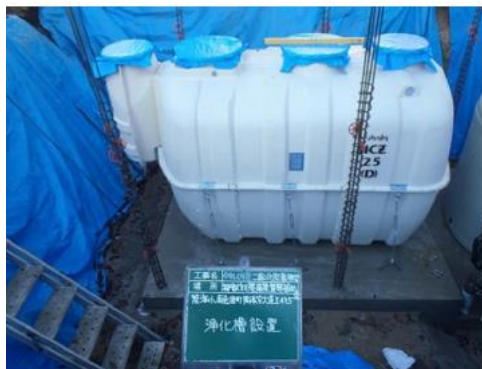
新設浄化槽 25人槽 搬入
