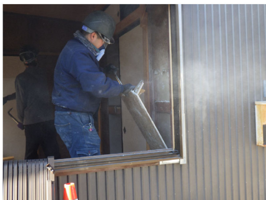
図2.11 石膏ボード解体作業状況
