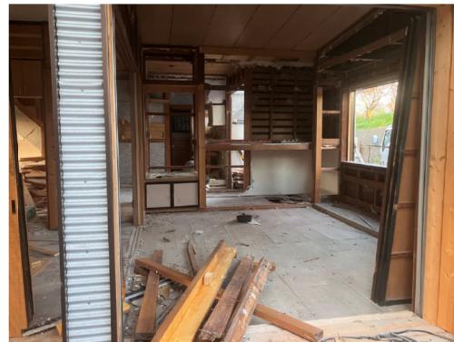
図1.1 解体工事物件の全景
