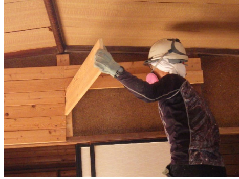
図 3.2-4 木材の解体状況
