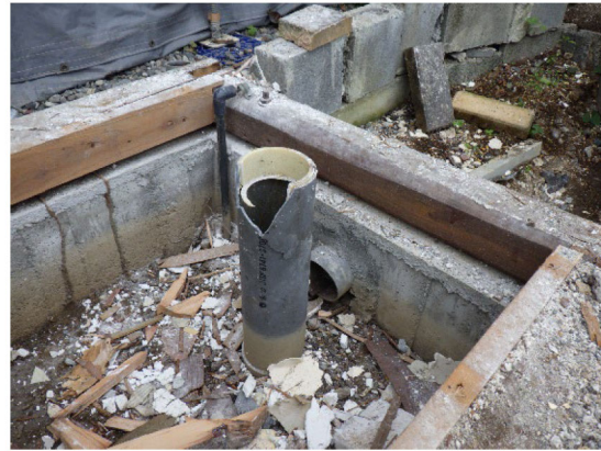
図2.6 塩ビ管の解体状況
