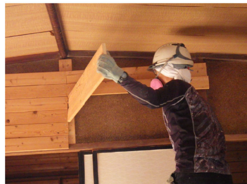
図2.4 木材解体状況
