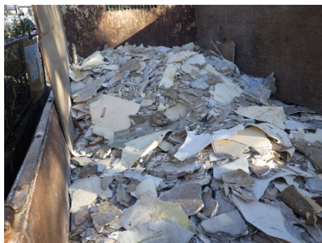
図 3.2-12 廃石膏ボードの分別・運搬状況
