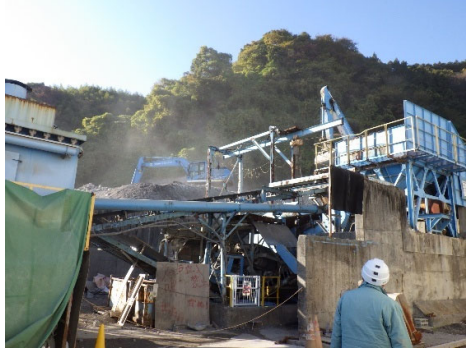
図 3.2-19 がれき類の破砕状況
