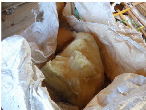
図2.7 グラスウール分別状況 (破損の有無にかかわらず、まとめて保管し搬出する。)
