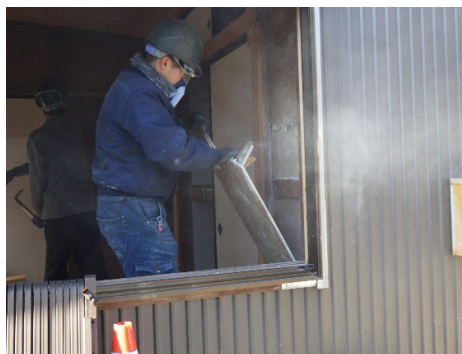
図 3.2-13 廃石膏ボードの解体状況
