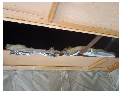
図 3.2-10 屋根裏の断熱材設置状況
