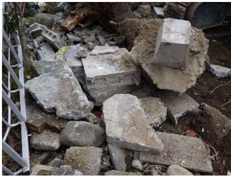
図 3.2-1 コンクリートがら及びがれき類 の分別状況
