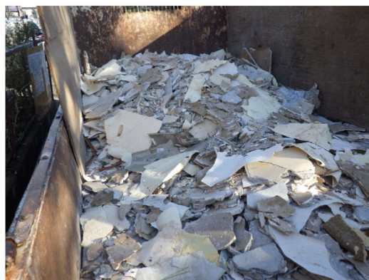
図2.12 石膏ボード分別・運搬状況 (大きさの大小関わらず、まとめて搬出)
