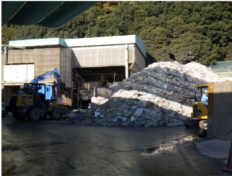
図3.10 廃石膏ボード分別状況
