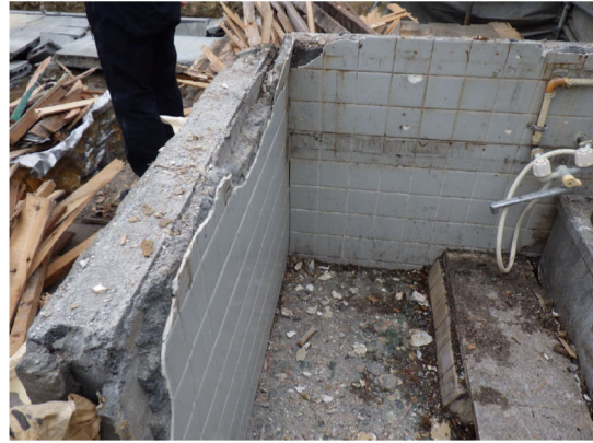
図2.2 コンクリート施工及び解体状況
