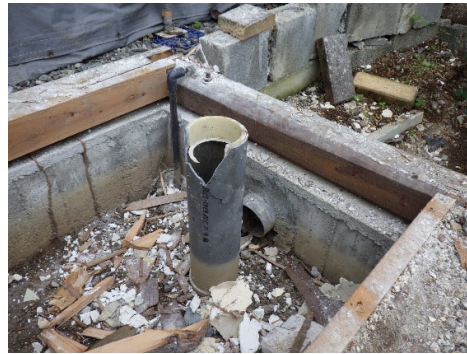
図 3.2-6 塩ビ管の解体状況
