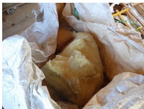
図 3.2-9 グラスウールの分別状況
