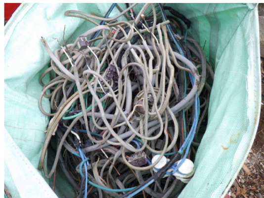
図2.14 コード類分別状況 (被覆内の銅線等を有価物として回収)
