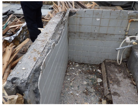
図 3.2-2 コンクリート施工及び解体状況
