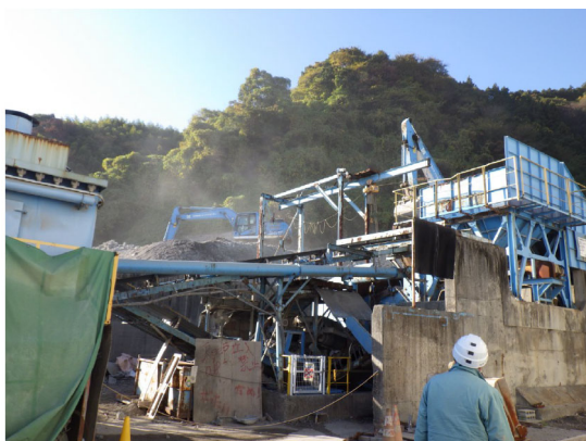
図3.3 がれき類破碎状況
