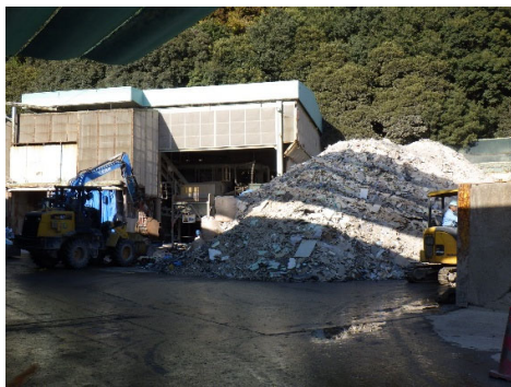
図 3.2-27 廃石膏ボードの分別状況
