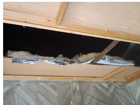
図2.8 屋根裏の断熱材設置状況
