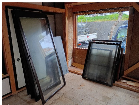
図 3.2-7 窓ガラスの分別状況
