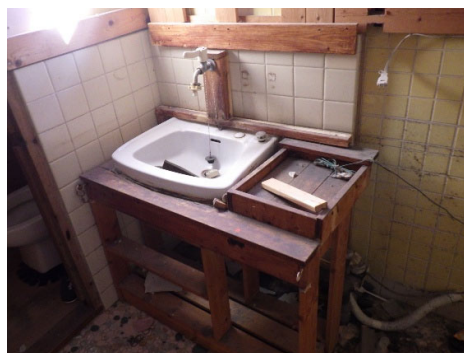
図 3.2-8 洗面台の解体状況
