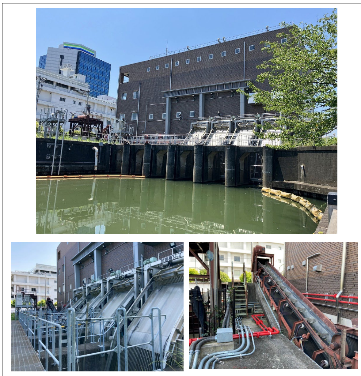
図 2-8 新川排水機場外観
