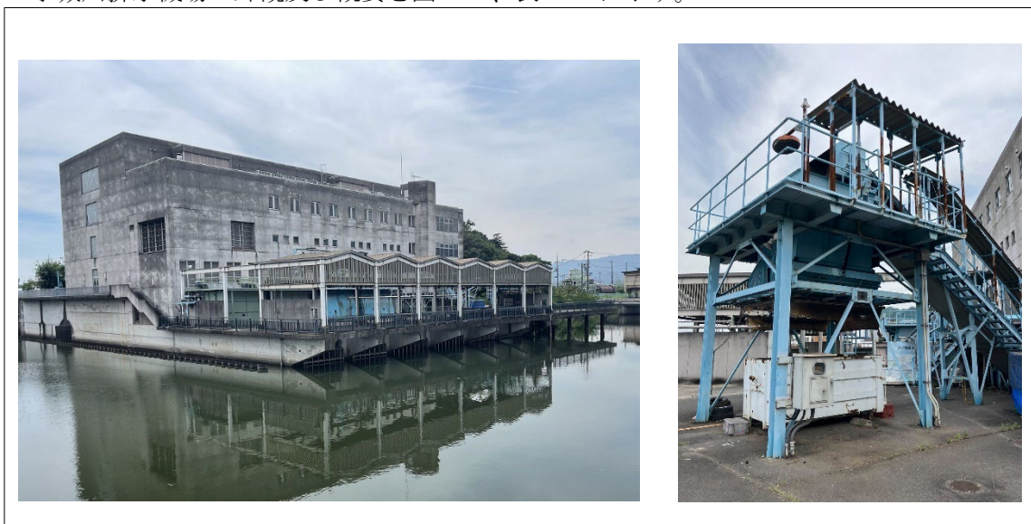
図 2-14 手城川排水機場外観
