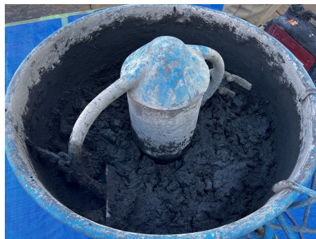
モルタルミキサー混合状況
