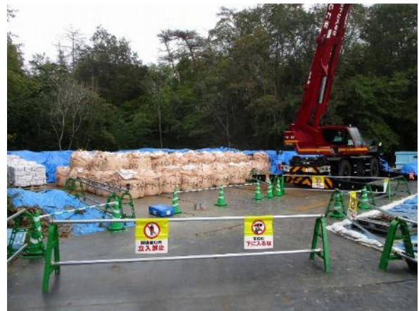
図-12 土壌試料仮置き・保管状況
