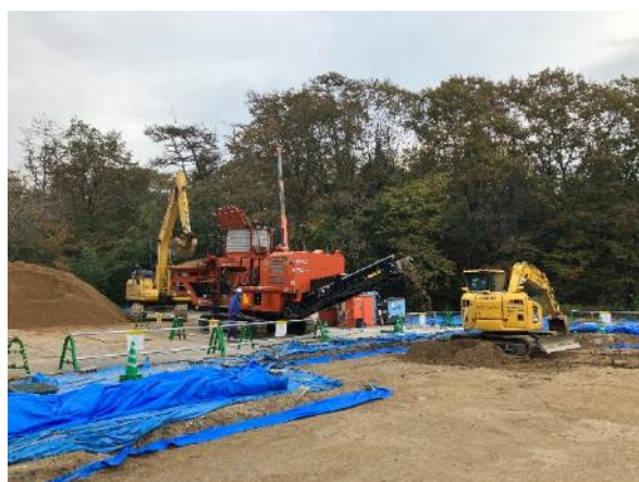
図-15 ベントナイト混合土調製・敷均し
