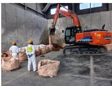
図-23 土壌試料開封状況
