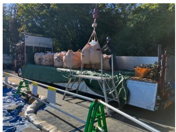
図-14 土壌試料積込・搬出状況
