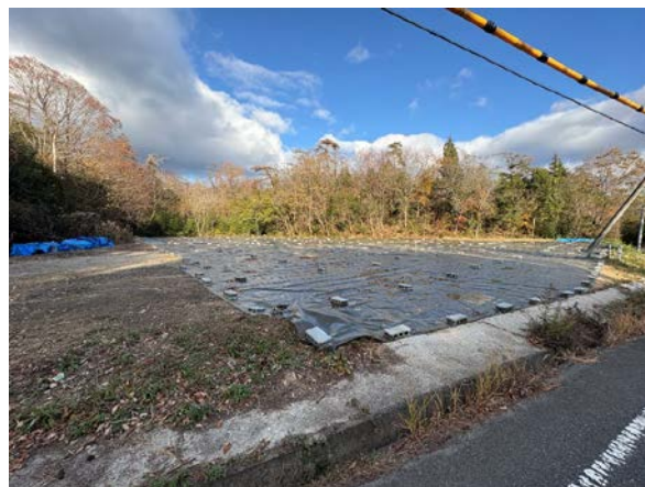
図-18 耐水シート敷設完了
