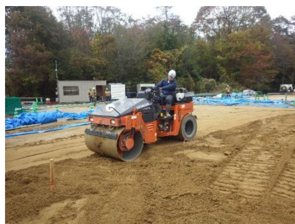
図-16 ベントナイト混合土転圧状況
