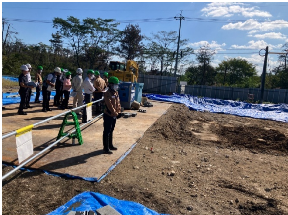
図-19 掘削場所現地視察1回目
