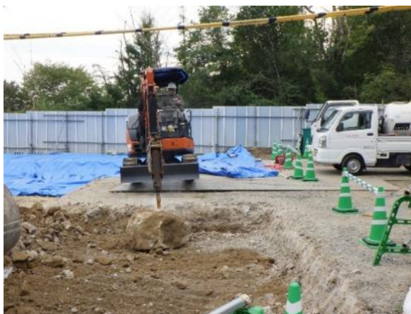
図-13 巨礫破碎状況
