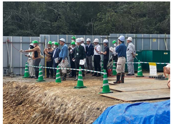
図-20 掘削場所現地視察2回目
