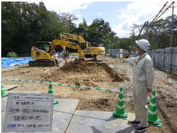
図-11 土壌試料掘削状況
