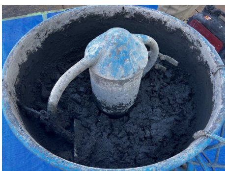
図 6 モルタルミキサー混合状況 (No. S3)
