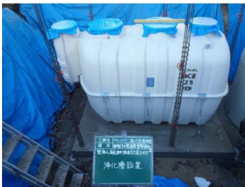
新設浄化槽 25人槽 搬入
