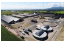
上士幌町の乳牛ふん尿を活用したバイオガスプラント 写真出所：脱炭素地域づくり支援サイト
