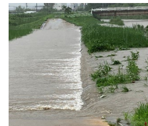
大雨時巴川から遊水地へ越流する様子
