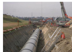
水路のパイプライン化
