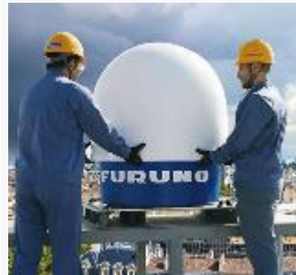
▲ 人力による設置が可能
