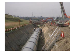
水路のパイプライン化
