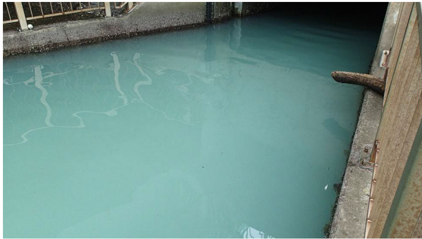
図 1-5 境川河口近くの暗渠前の様子 (この暗渠は河口より 200mほど上流の左岸に位置する)
