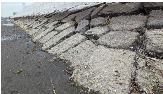
①高潮堤防礎石部分
