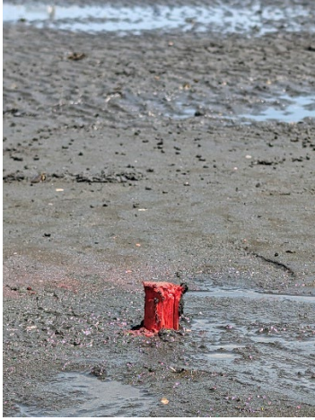
②A0 地点木杭
