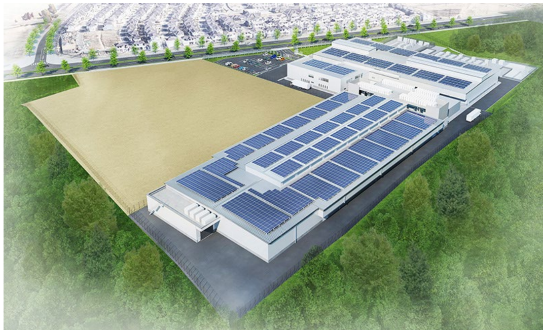
白井データセンターキャンパス 2期棟
