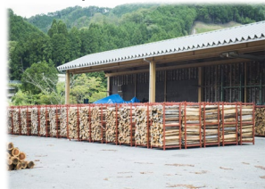
木質バイオマス施設
