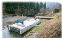
小水力発電施設
