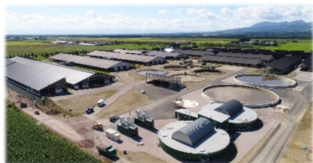
バイオガスプラント
