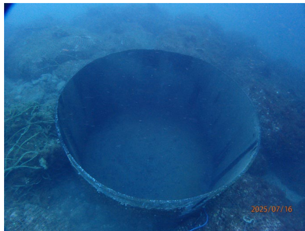
写真 第二期工事前ににおける基礎モノパイル内側の土砂入り込み状態
