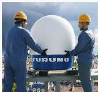
▲人力による設置が可能
