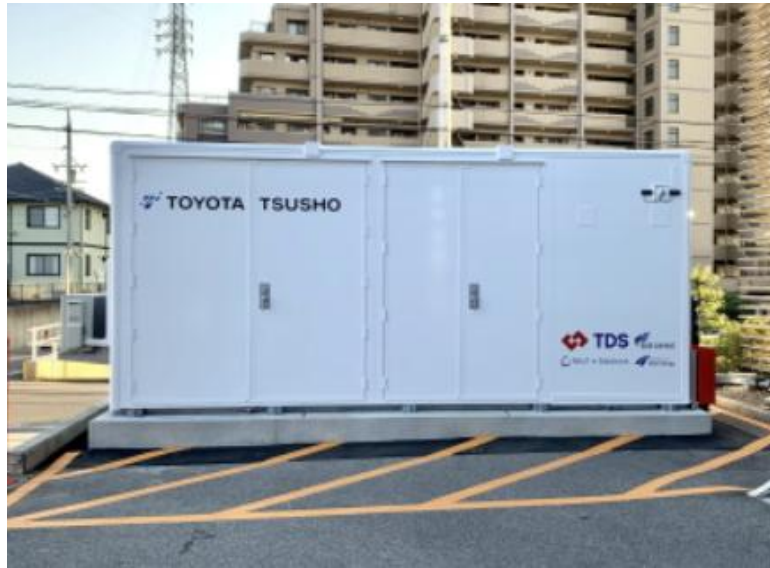
図表 19 EV リユース電池を内蔵したビル用蓄電池コンテナ
