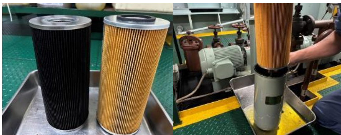
図 57：碇泊発電機燃料フィルターおよび内部エレメント (左：取り出した内部エレメントと新品の比較、右：内部エレメント交換)
