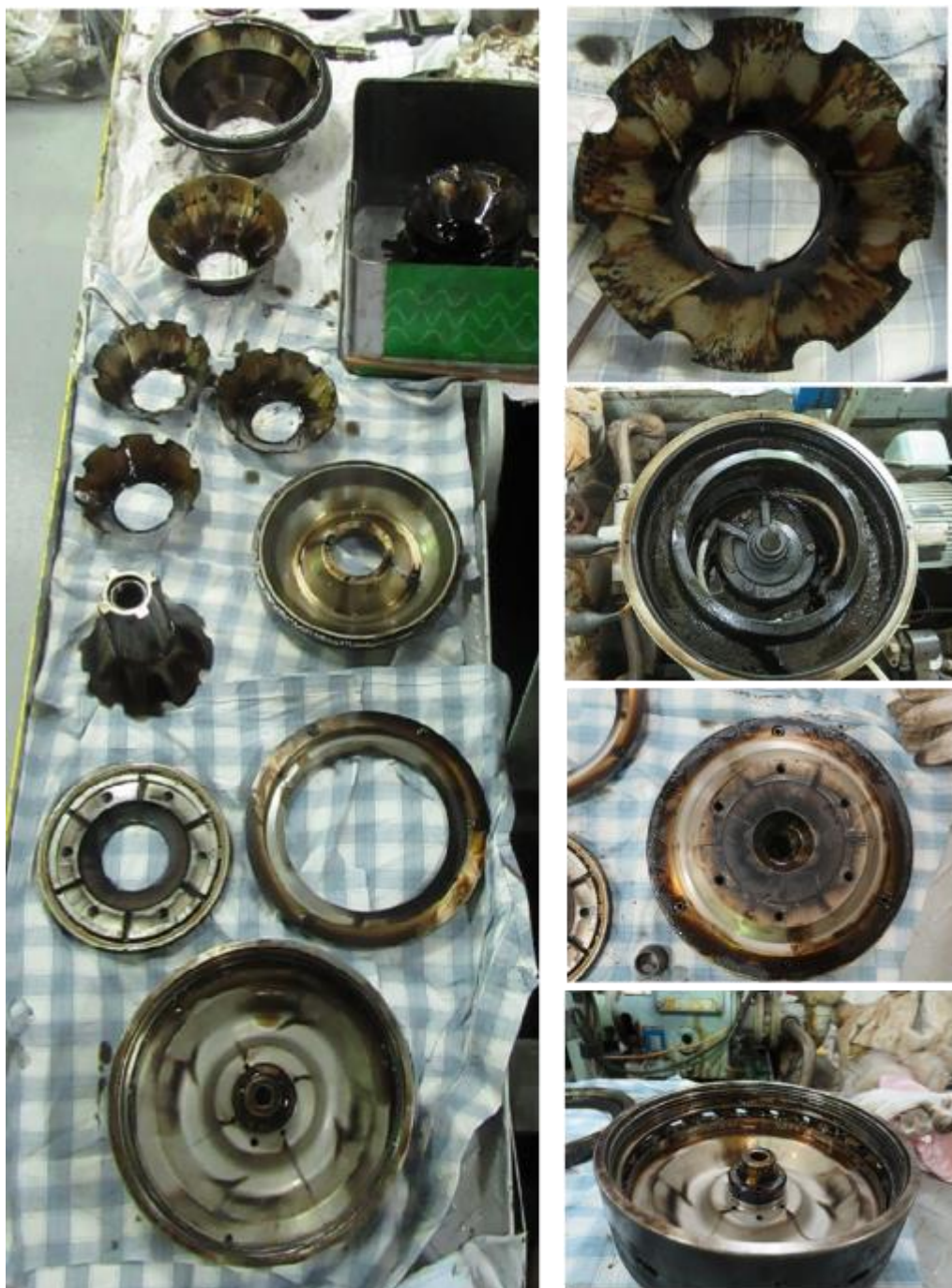
図 34：燃料清浄機の開放点検
