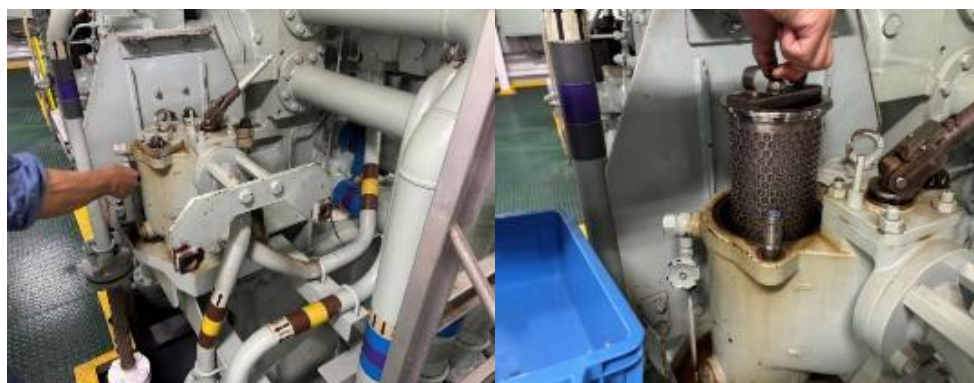
図 55：主発電機関の燃料フィルターおよび内部エレメントの取り出し
