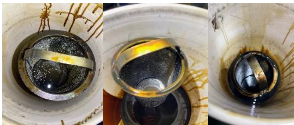
図 40：運航実証後（624 時間後）におけるストレーナー内部 (左より移送ポンプ、燃料清浄機、燃料供給一次)
