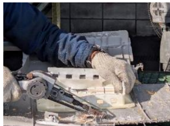
(D) 二次解体（吸音材の剥離）
