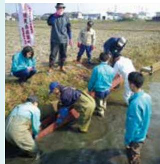
④ 集落総出で魚道を設置
