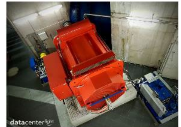
Data Center Light内の水力発電ユニット
