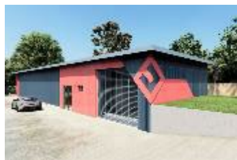
Edge Centres EC5 Albury (最大消費電力：150kW)
