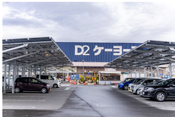
写真 ソーラーカーポート設置状況
