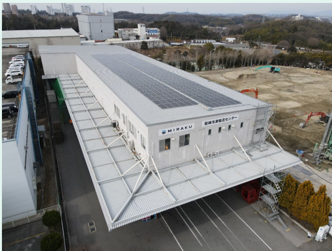
太陽光発電設備
