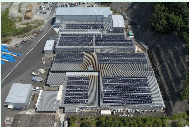
太陽光発電設備
