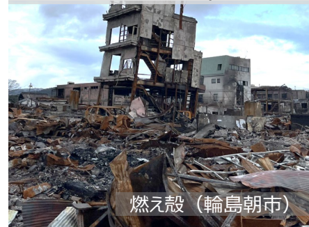
埋め立てざるを得ない廃棄物の例
