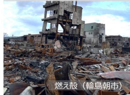
埋め立てざるを得ない廃棄物の例
