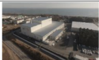
大熊町の仮設焼却施設(2017年12月)
