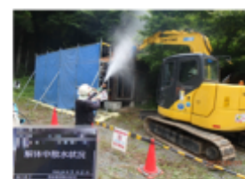
被災家屋等の解体の様子 環境省作成
