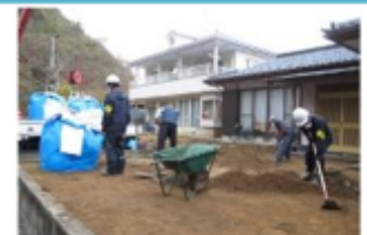
●庭土等の土壌の削り取り (提供) 伊達市
