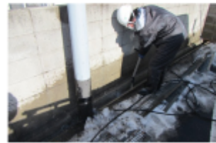
●側溝の汚泥の除去 (提供) 福島市
