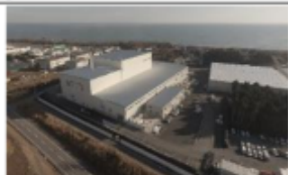
大熊町の仮設焼却施設(2017年12月)
