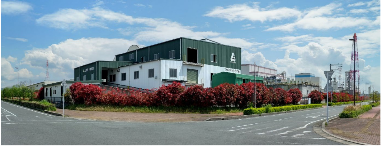
図 5-2 再生利用等施設の外観
