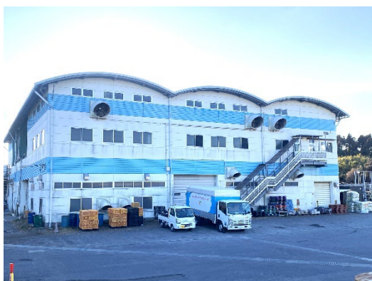
図 5-7 再生利用等設備の概観(実証施設)
