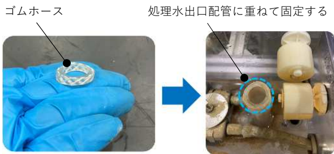
図 2-14 処理液面高さの調整方法
