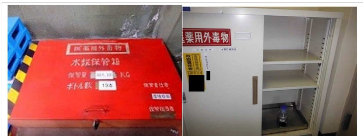
図 2.4 水銀等の貯蔵場所の例 その２
