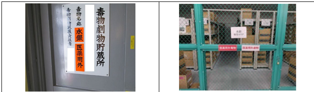
図 2.3 水銀等の貯蔵場所の例 その１
