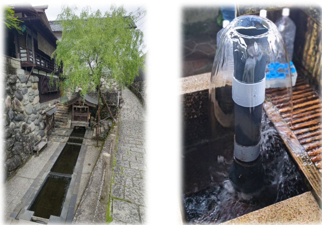
左：湧水と水船（岐阜県郡上市 「宗祇水」、右：自噴井戸（岐阜県大垣市 「曾根華溪寺の福水」）
