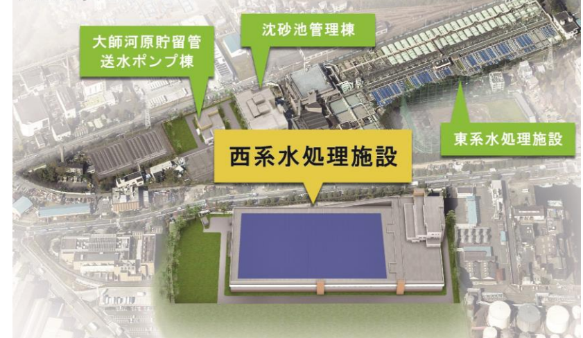
入江崎水処理センター
