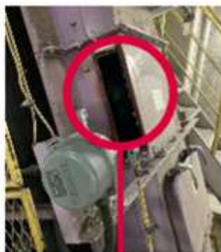
直接消火が行いづらいコンベヤ部分に、新たに消火用の穴を複数設けた。
