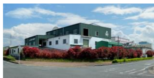
リサイクル施設の外観
