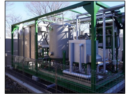
町内生ごみ等を原料とする メタン発酵バイオガス発電
