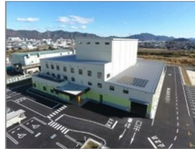
容器包装リサイクル推進施設
