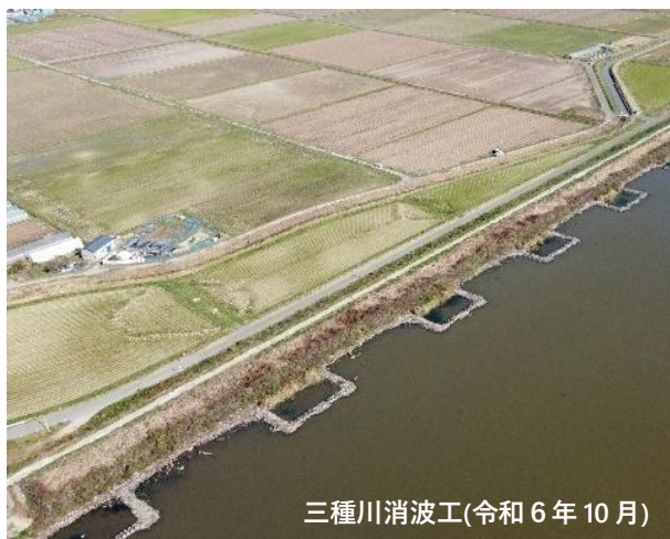
図39 消波工の設置状況
