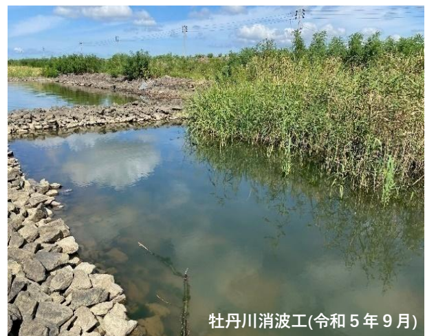
図40 消波工内の植生の状況
