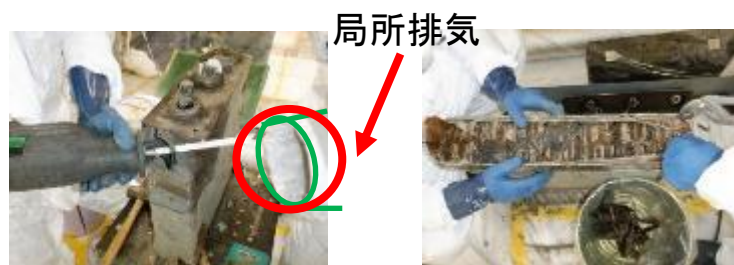
コンデンサー解体作業
