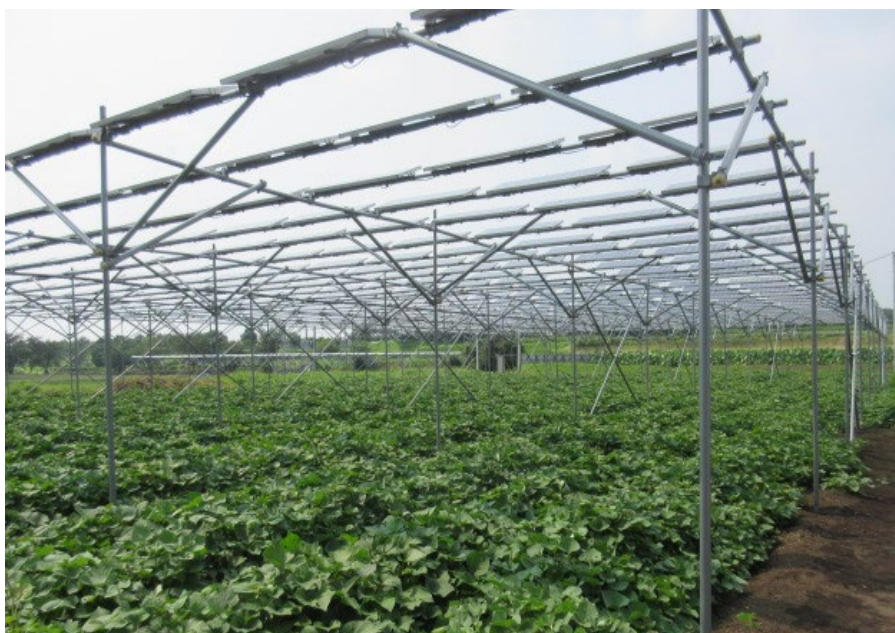
露地の畑の上部にパネルを設置
