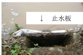
止水板の設置
