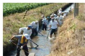
農業用水路の泥上げ
