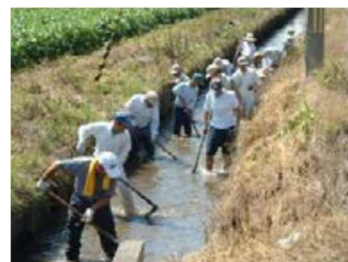
農業用水路の泥上げ
