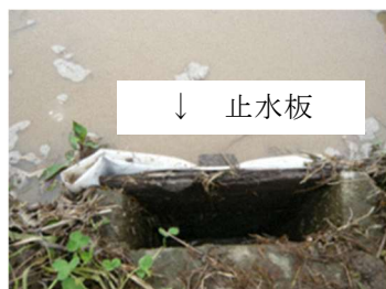
止水板の設置
