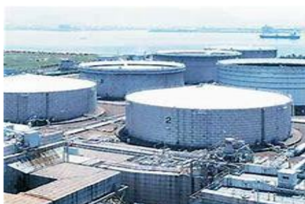
石油貯蔵タンク
