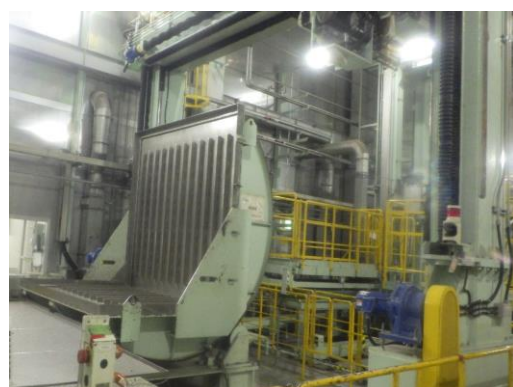
大型トランス粗解体装置
