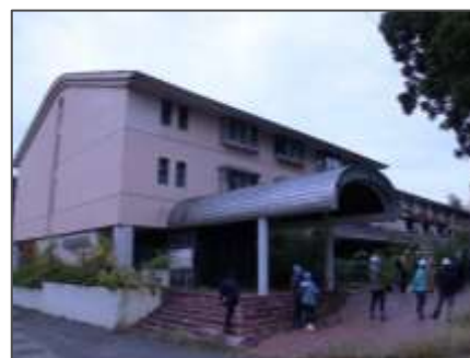
湖畔方向の景観（廃屋撤去前）
