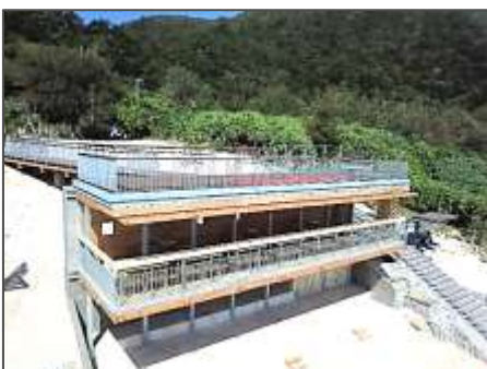
ニシバマテラスの全景写真
