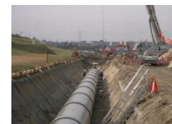
水路のパイプライン化
