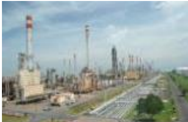
石油精製プラントの運転制御最適化（横河電機）
