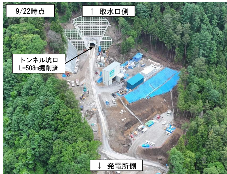
取水口と発電所をつなぐ水圧管路一体型トンネルを掘削中
