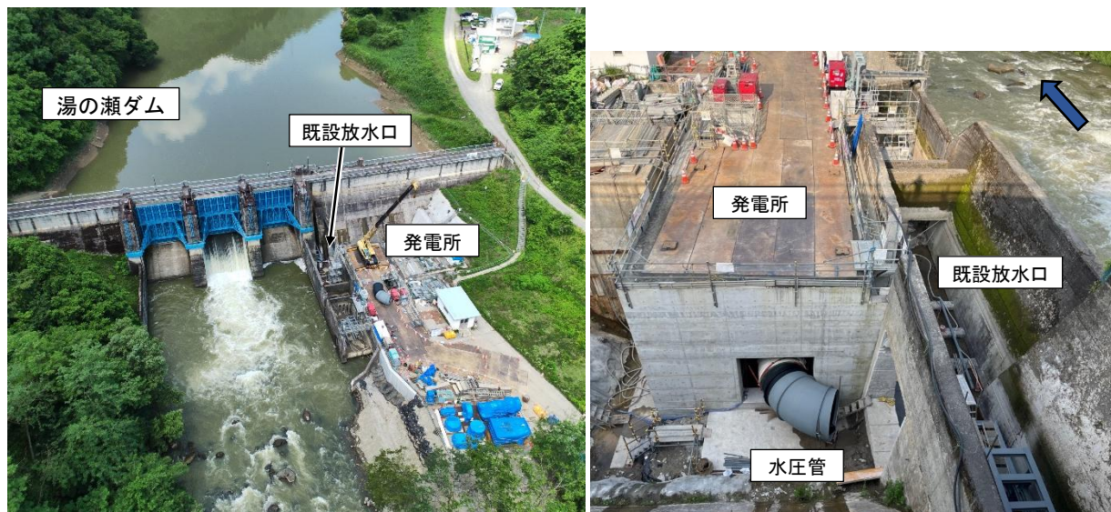
既設放水口から分岐し、発電所へ接続する水圧管の敷設中
